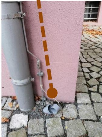
Das **Schmutzwasser/Abwasser** aus dem Weinstand, Ableitung über einen Schlauch in den Ablauf am Regenfallrohr.
