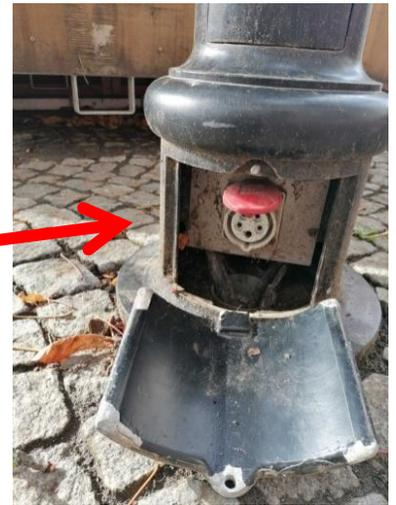
Auch in den anderen Laternen auf dem Gelände sind Steckdosen für Kraftstrom vorhanden (**CEE 5-polig, 400 Volt, 16 Ampere**, z.B. für den Anschluss eines Kühlwagens).
