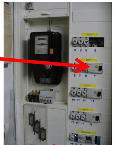
Die **Beleuchtung des Platzes mit den Laternen** hier zentral schalten (Ein, Aus, Schaltuhr). Anleitung im Zählerschrank.
